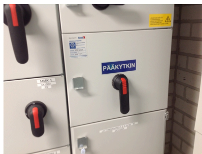
Sähköpääkytkin
