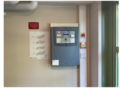
Paloilmoitinkeskus, ilmanvaihdon hätäseispainike, savunpoiston etälaukaisu ja savunpoistokaavio
