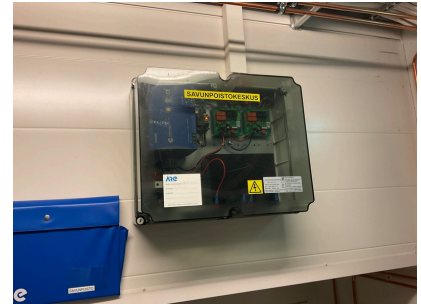
Savunpoistokeskus ilmanvaihtokonehuoneessa
