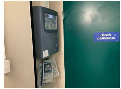
Paloilmoitinkeskus A-talon B- rapun sähköpääkeskuksen vie- ressä
