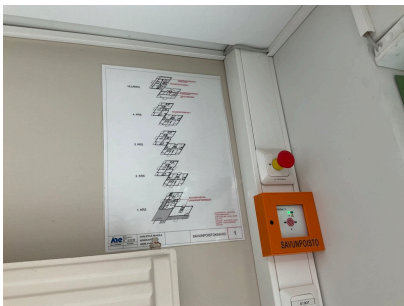
Ilmanvaihdon hätäseispainike, savunpoiston etälaukaisu ja savunpoistokaavio
