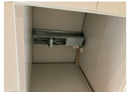
Savunpoistoluukku A-talon B-rapussa ja B-talossa
