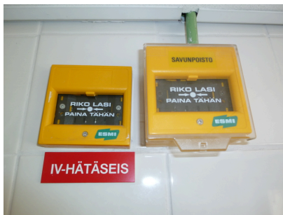
IV-hätä-seis, sisäänkäynnin yhteydessä
